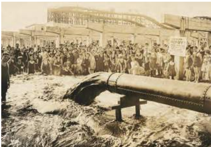
Figura 9. Coney Island, NY (1923): il primo mega-ripascimento fatto sulle coste del mondo con 1.300.000 m 3 di sabbia dragata in quattro siti distanti da 500 a 1200 m dalla costa (NYC Municipal Archives Digital Collections).
